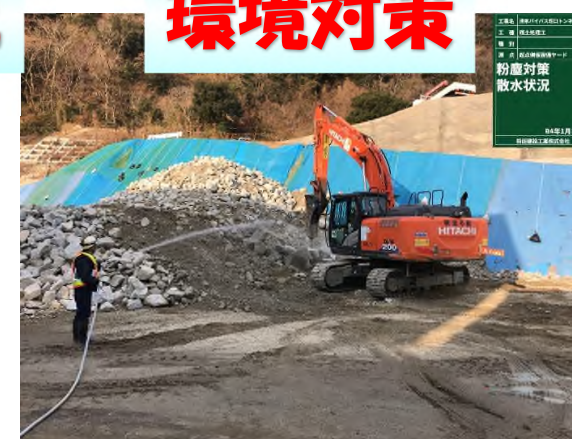
粉じん対策 散水状況
